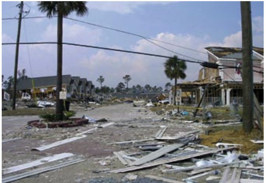
Les ravages causés par l'ouragan Katrina à Gulfport, Mississippi, États-Unis. L'ISO/TC 223 élabore des normes pour améliorer les dispositifs en place et la capacité d'intervention face à de telles catastrophes. Photo : Rick Earls.
